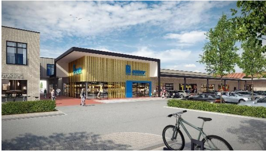
Ansicht des Nahversorgungszentrums im Süden.
