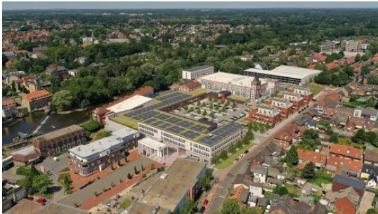
Neugestaltung des EEC in Rheine von oben: die historische Spinnerei im Norden – zeitgenössische Neubauten im Süden.
