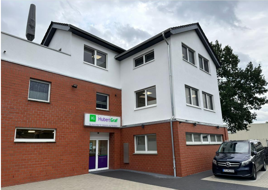
Nachverdichtung mittels Aufstockung im Bestand - Hubert Graf Technische Geräte GmbH zeigt wie es geht.
