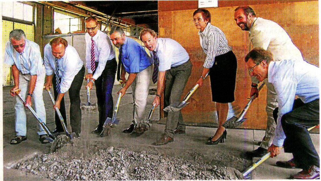
Gemeinsam packten die Projektbeteiligten beim ersten Spatenstich für den neuen Bahnhofstunnel an.
