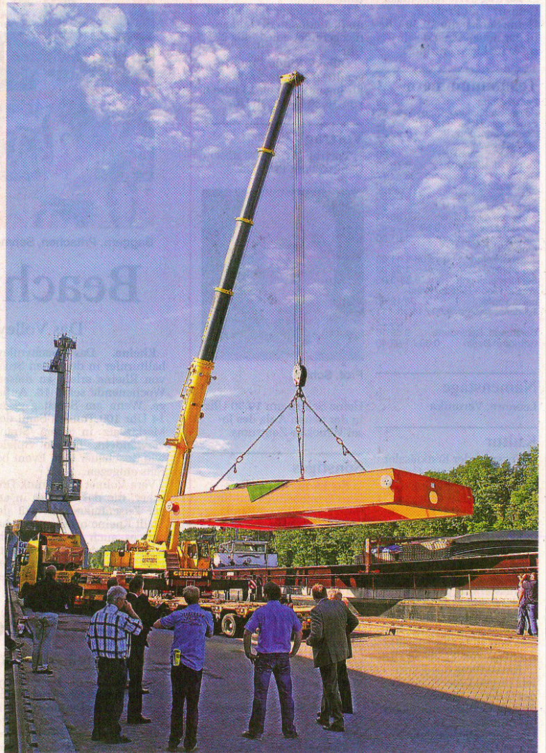
Per Autokran wurde das knapp 40 Tonnen schwere Bauteil auf das im Speller Hafen festgemachte Schiff verladen.
