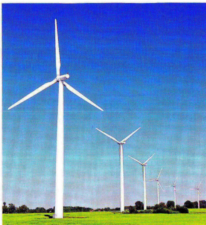
Vernetzt: Die Windenergiebranche rund um Rheine.
